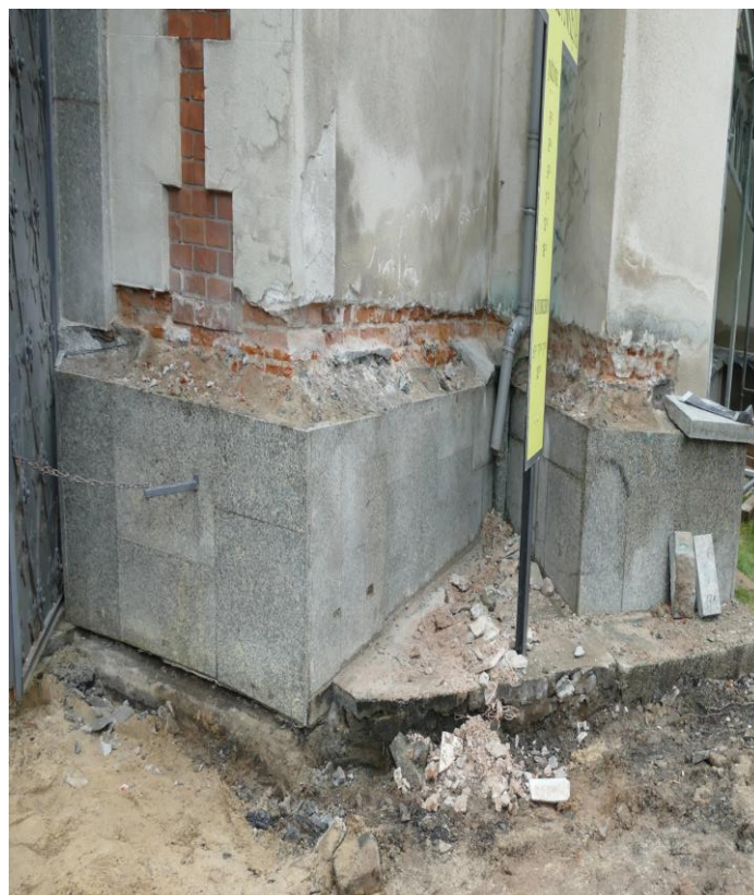
Łańcut, kościół, cokół w przyziemiu, stan w trakcie konserwacji. Autor fot. Jerzy Śliwa, 2018 r.
