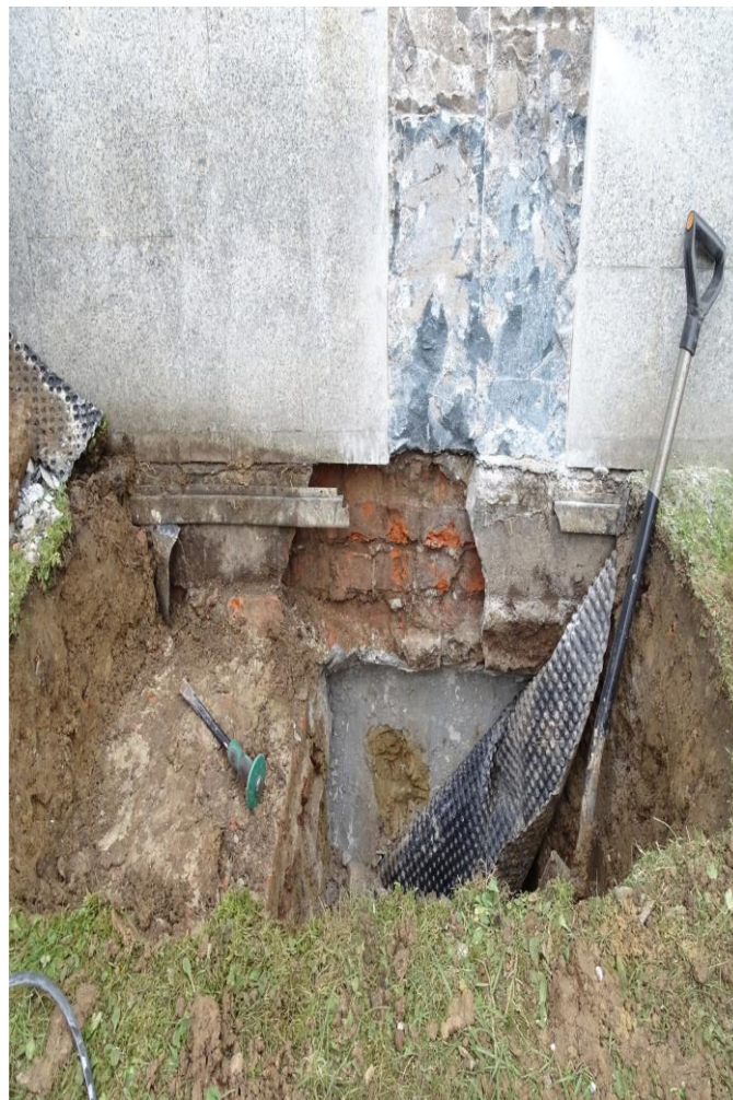
Łańcut, kościół, cokół w przyziemiu, stan w trakcie konserwacji. Autor fot. Jerzy Śliwa, grudzień 2017 r.
